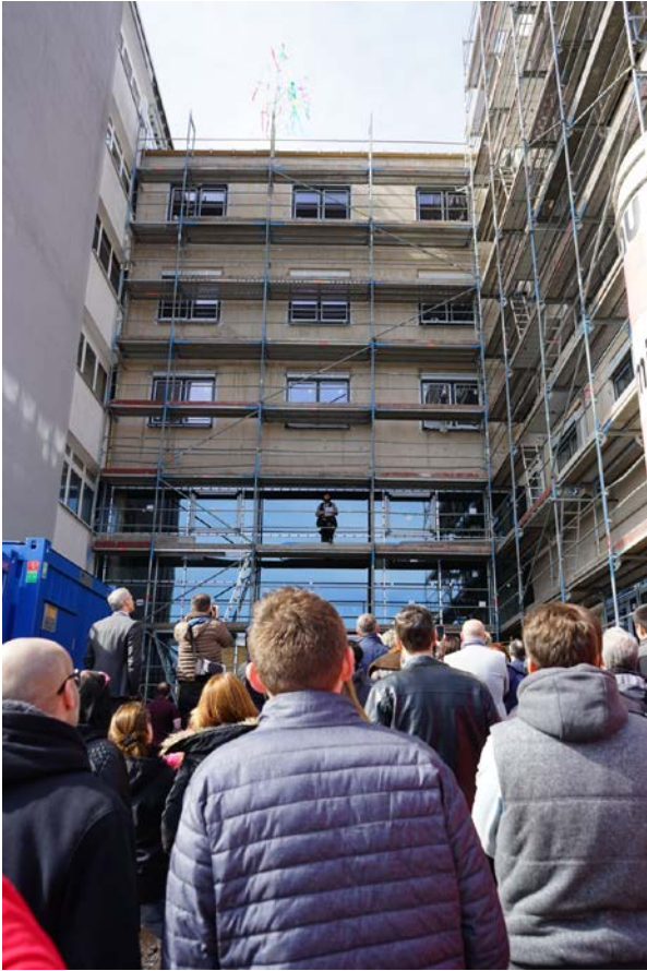
Beim Richtspruch vor dem zukünftigen Haupteingang.
